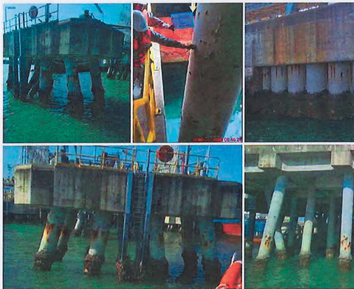
Fig. 3: : Jetty Piles Current Situation
