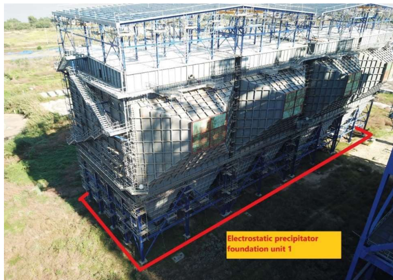
Mô tả phạm vi thiết bị lọc bụi tĩnh điện (ESP) Tổ máy số 1
